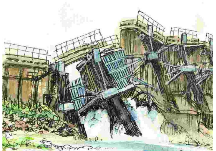
高低差約 10 メートルに及ぶ断層の大きなずれによって破壊された石岡ダム。（発災当初の状況）
